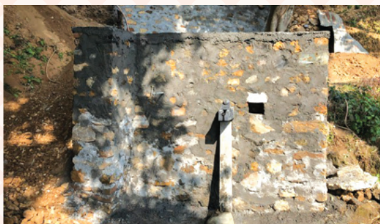
जुँगे पेंधेरा ढुङ्गेधारा निर्माण
