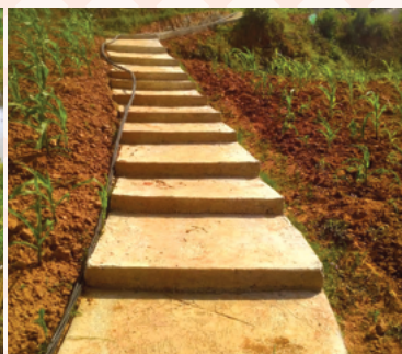
नयाँगाउँ चौतारा गोरेटो बाटो सिढी निर्माण तथा नाला सरसफाई
