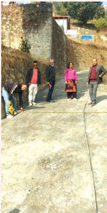
ढकालखोला तालिम केन्द्र सडक पक्की निर्माण
