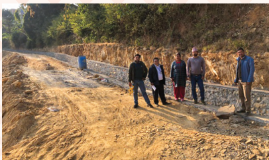
छत्रेदेउराली सामाजिक उद्यमी महिला सहकारी जाने सडकमा पक्की नाली निर्माण कार्यको अनुगमन
