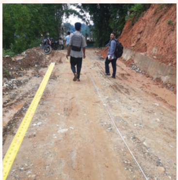
डाडागाउँ चौतारा पिपलबोट सडक निर्माण
