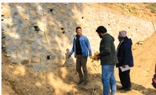
गोरखकाली मास्टारी सडक टेवा पर्खाल निर्माण कार्यको अनुगमन
