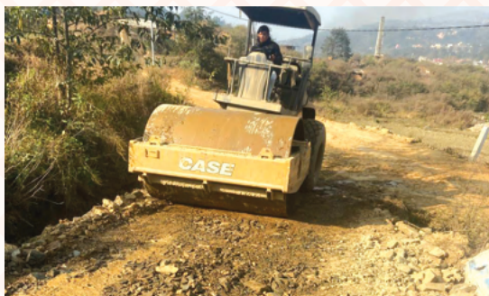
ओल्लो गहते पल्लो गहते सडक स्तरोन्नति
