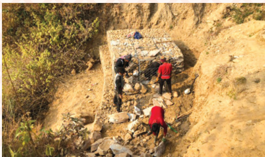
न्यौपानेखोला मास्टारी सडक जाली वाल निर्माण
