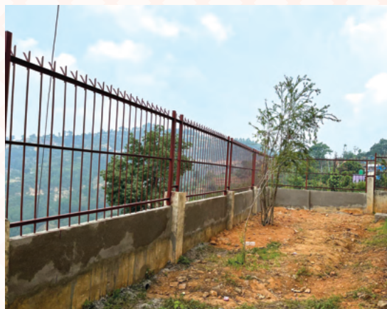
वडा कार्यालय भवन कम्पाउण्ड निर्माण
