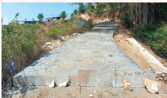
तेर्सैपनि कोटकालिका खानीगाउँ सडक ढलान
