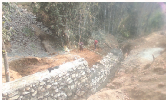
सोतिखोला तटबन्ध निर्माण
