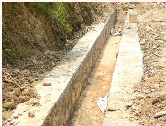
भदौरै मुखिया टोल सडक नाली निर्माण
