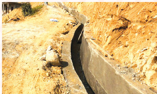
गैराथोक बस्नेतगाउँ सडक पक्की नाली निर्माण
