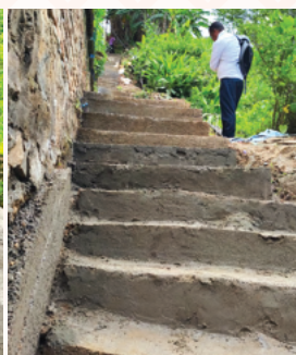
नौबिसे कुलो देखि कानडाँडा जाने बाटो सिँडी निर्माण
