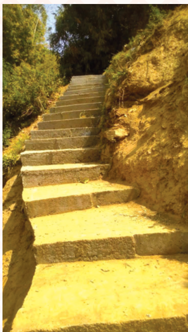
कोलडाँडा गोरेटो बाटो निर्माण
