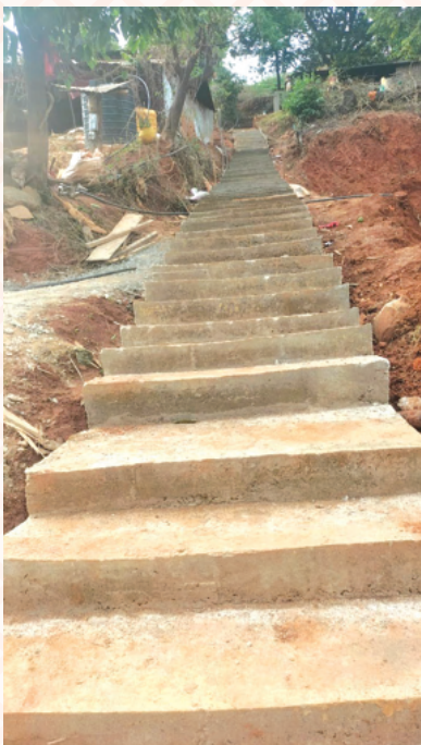
बद्रिटार देवीथान राइगाउँ सिढी निर्माण
