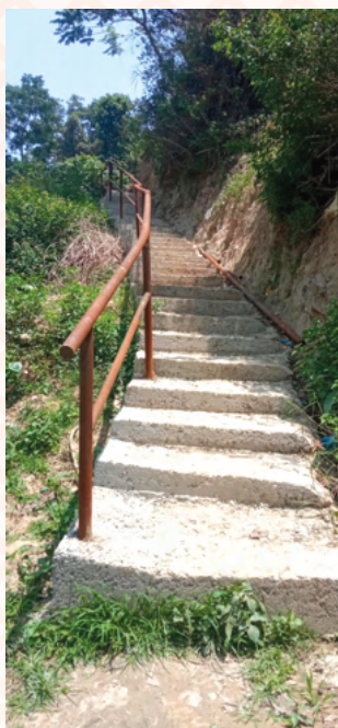
कात्तिके खोला कालिका आ.वि गोरेटो बाटो सिढि निर्माण
