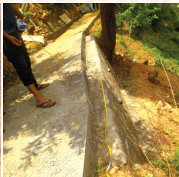
मगरगाउँ गोरेटो बाटो निर्माण
