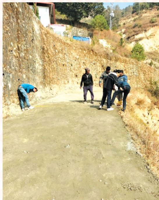
ढकालखोला तालिम केन्द्र सडक पक्की निर्माण
