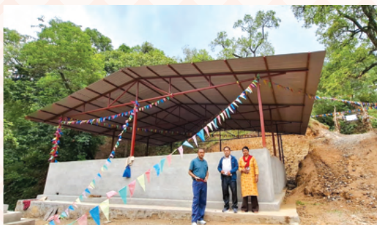
खत्रीथोक कोलडाडा पाटी तथा ट्रस निर्माण
