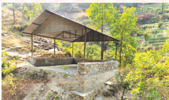
तल्लो लप्से गुठी भवन निर्माण
