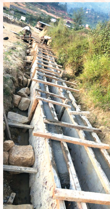
पिपलामोड महेशफाँट सडक पक्की नाली निर्माण
