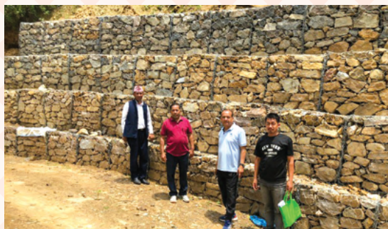
मानेडाँडा कामीटार सडक जाली वाल निर्माण अनुगमन
