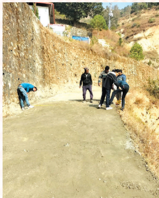
ढकालखोला तालिम केन्द्र सडक पक्की निर्माण
