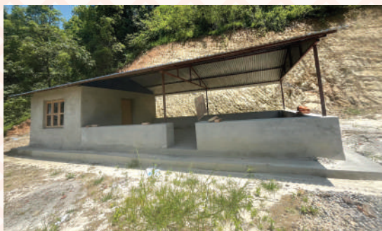
दमाहा डुङ्गा गाउँघर क्लिनिक निर्माण
