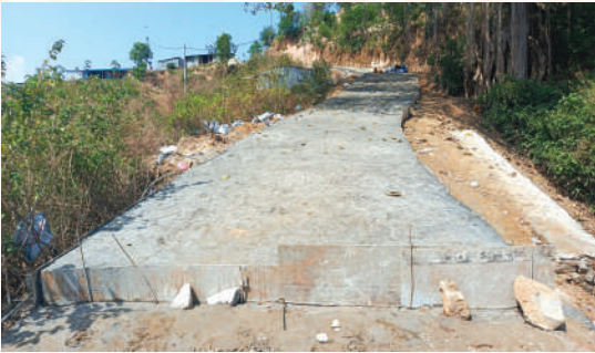
तेर्सैपनि कोटकालिका खानीगाउँ सडक ढलान
