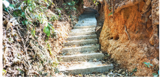
तल्लो बिरौटो रुपाखेती गाउँ गोरेटो बाटो सिढी निर्माण
