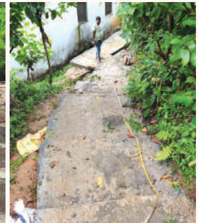
भट्टामोडा हेल्थपोस्ट सिँडी निर्माण
