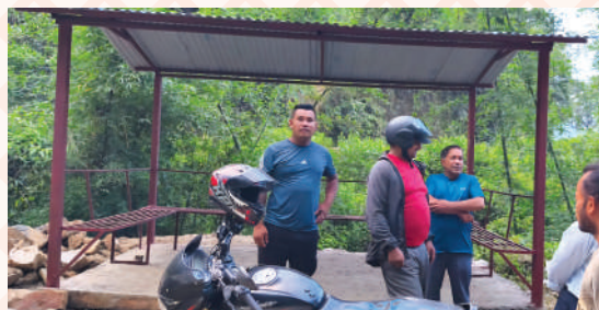
चेपाङ खोल्सा प्रतिकालय निर्माण
