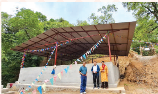
खत्रीथोक कोलडाडा पाटी तथा ट्रस निर्माण
