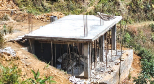
लिखु कृषि भवन निर्माण
