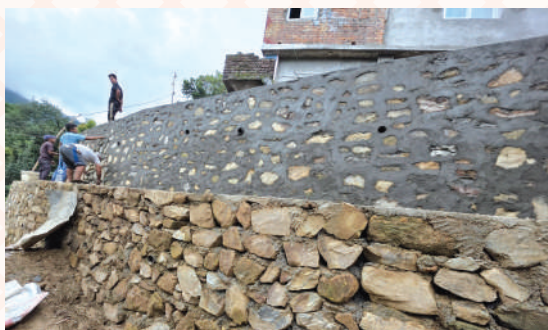
फाल्टुडी गोरेटो बाटो सिढी निर्माण तथा बस्ती संरक्षण
