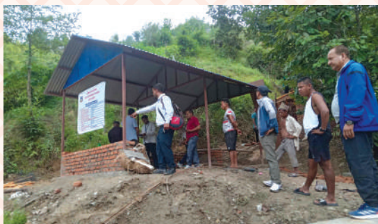
चमेलीखोल्छी पात्लेपानी ऋषि मन्दिर ट्रेस निर्माण
