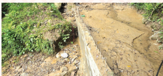
जामुनेफाँट सिंचाई कुलो निर्माण
