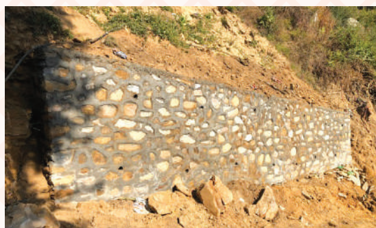
खत्रीगाउँ चाँपेचौतारा सडक वाल निर्माण
