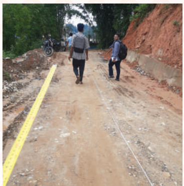
डाडागाउँ चौतारा पिपलबोट सडक निर्माण
