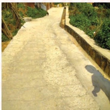
दमदमे गोरेटो बाटो निर्माण
