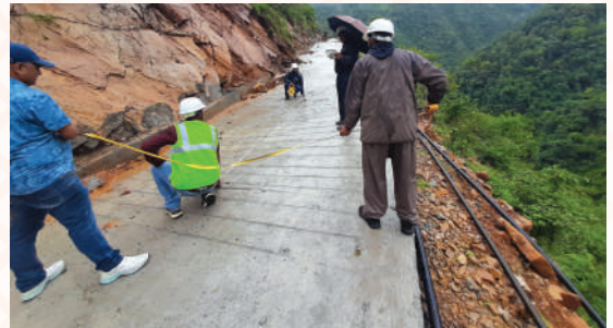
नौबिसे दोभान सडक निर्माण
