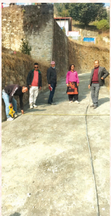
ढकालखोला तालिम केन्द्र सडक पक्की निर्माण
