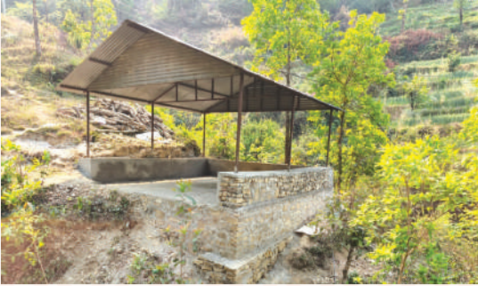
तल्लो लप्से गुठी भवन निर्माण
