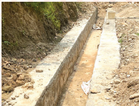
भदौरै मुखिया टोल सडक नाली निर्माण
