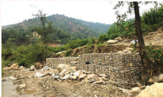
महेशखोला तटबन्धन निर्माण
