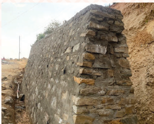
टापु पञ्चकन्या देवि सडक वाल निर्माण
